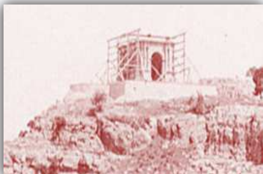
Le monument en cours de construction, octobre 1929.
